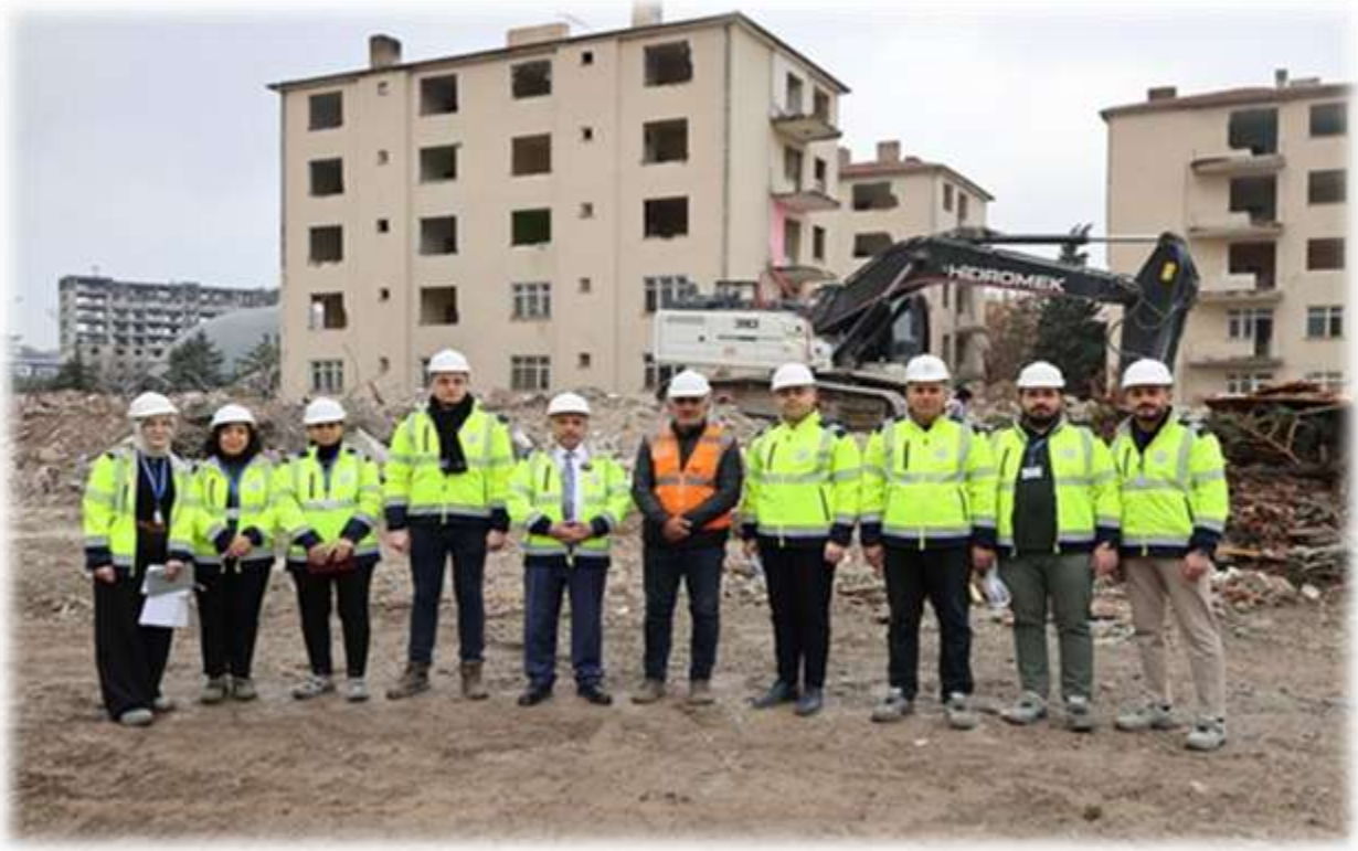
Harman Mahallesi Kentsel Dönüşüm ve Gelişim Projesi 2. Etap (Erciyes Sitesi- Cemilbaba Sitesi – Hatipoğlu Sitesi) Yıkım Aşaması
